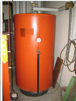
Bild 7 Industriebetrieb (2007): 500 Liter WW-Peicher + 20 m² Kollektorfläche
