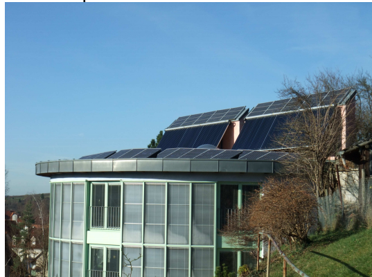
Passiv-Einfamilienhaus (2009): 0,8 m 3 Aqua Espresso + 26 m 2 Kollektorfläche
