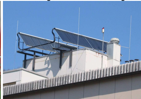
Bild 7 Industriebetrieb (2007): 500 Liter WW-Peicher + 20 m² Kollektorfläche
