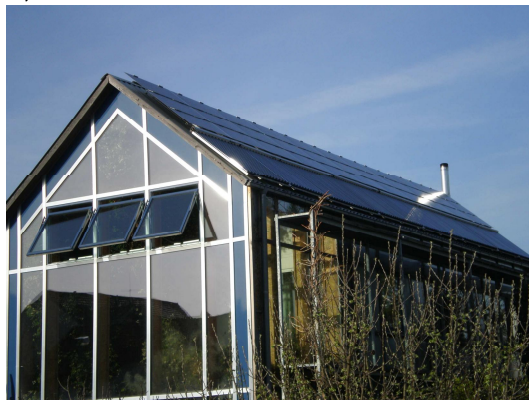
Passiv-Einfamilienhaus (2000): 2,2 m 3 Optima Power Isoplus + 27 m 2 Kollektorfläche
