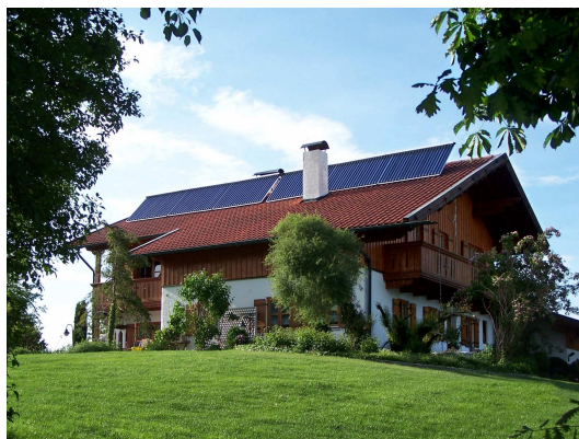
Wohnhaus mit Bürofläche (2005): 1,5 m 3 Puffer + 26 m 2 Kollektorfläche
