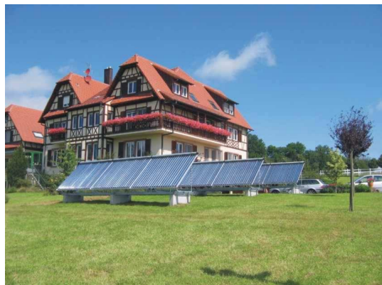
Einfamilienhaus (2007): 1 m 3 Puffer- + WW-Speicher + 44 m 2 Kollektorfläche
